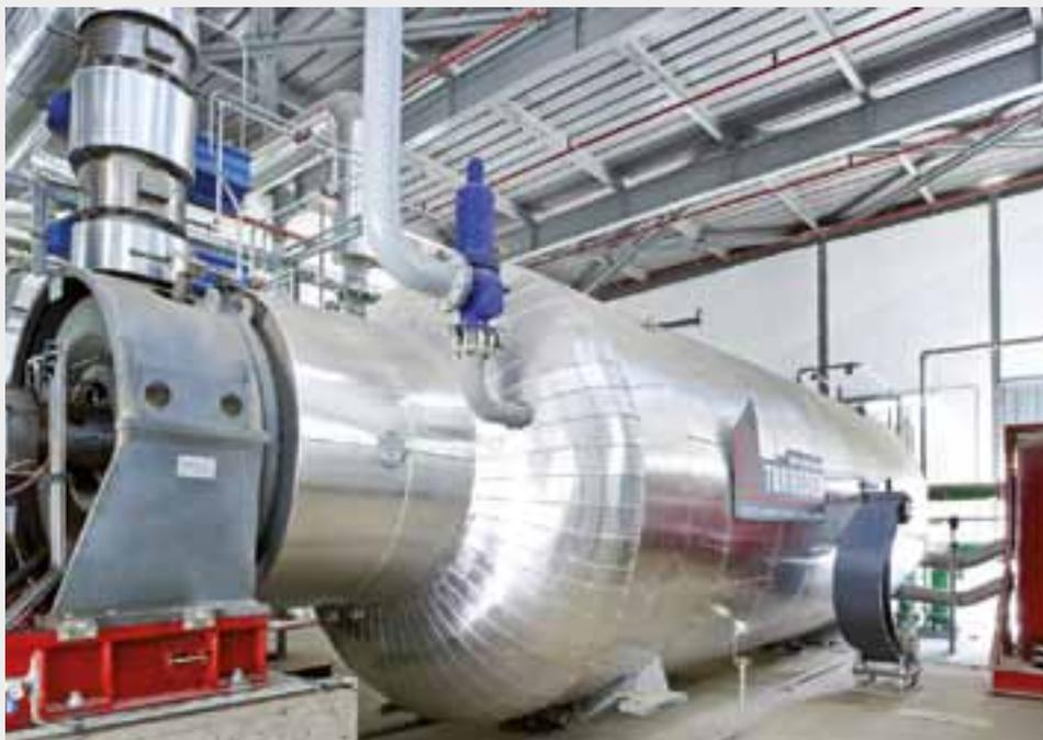
Unità ORC Turboden da 1,5 MW elettrici per recupero di calore di scarto da processi industriali, installata presso il cementificio di Ait Baha di Italcementi.
